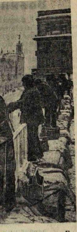
Строительство жилого корпуса «Е» на улице Горького (Москва). Одновременно с кладкой стен производится облицовка фасадов. На снимке: лепщики устанавливают облицовочные плиты.
