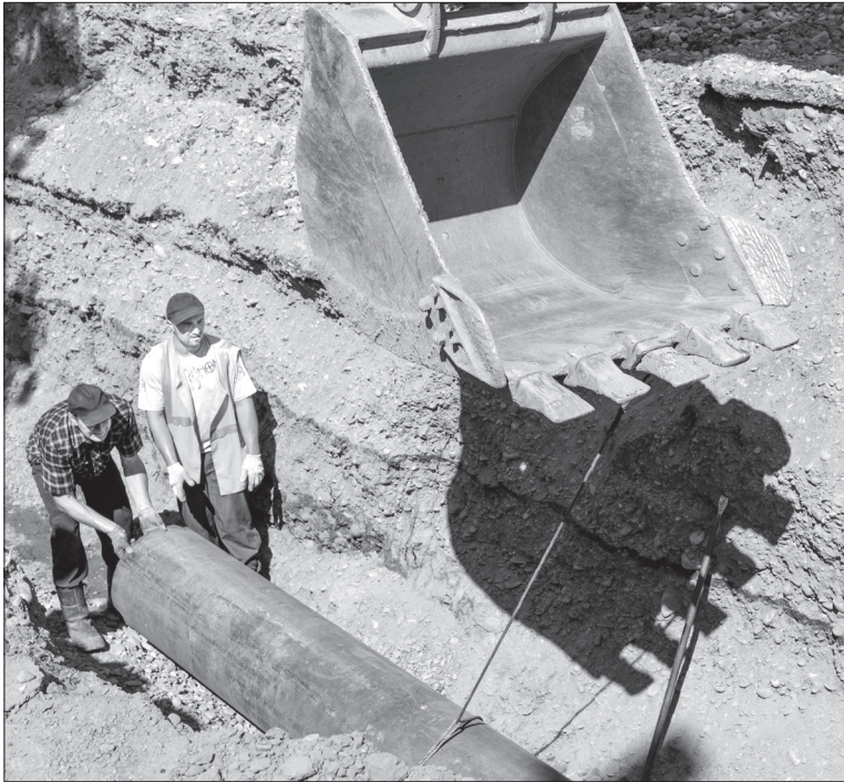
Своевременный ремонт теплотрассы — залог гарантированного теплоснабжения зимой. ФОТО: АЛЕКСАНДР КОЛБАСОВ, АРХИВ «ХАКАСИИ»
