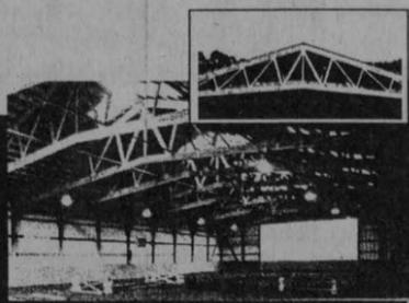
Высокоэкономичные стропильные фермы и межэтажные перекрытия из дерева по оригинальной американской технологии, ширина пролета до 30 м.
