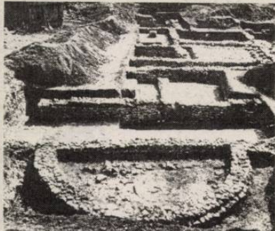
Šćitarjevo - iskopine rimskog kupališta
