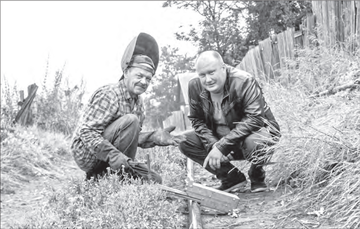
Рабочие варят трубы в перерывах между дождём. ФОТО: ТАТЬЯНА ГОЛОВКОВА, «ХАКАСИЯ»
