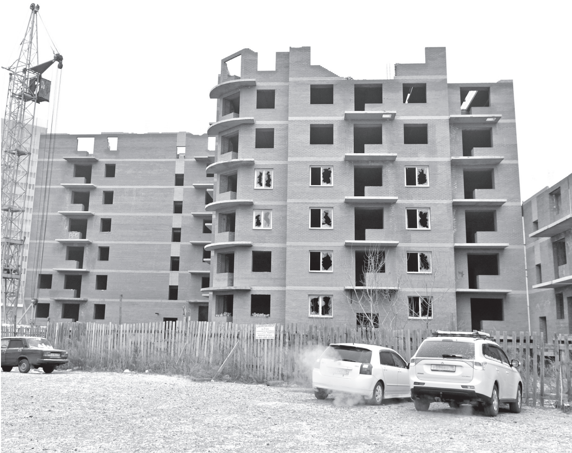
Строительство многоэтажки по улице Дружбы Народов, 41, в Абакане возобновится в 2022 году. ФОТО: СТАНИСЛАВ ПОБЕЛЯЕВ, «ХАКАСИЯ»
